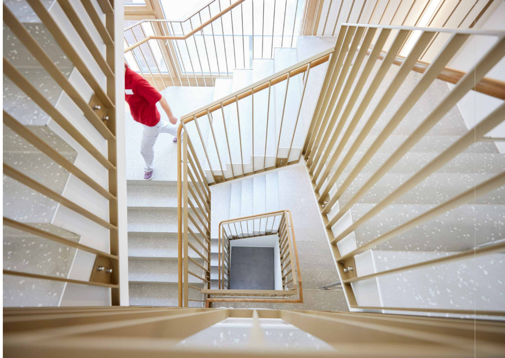
Nach dreijähriger Umbauzeit besticht der Spannort durch seine Ästhetik und multifunktionalen Räume.
